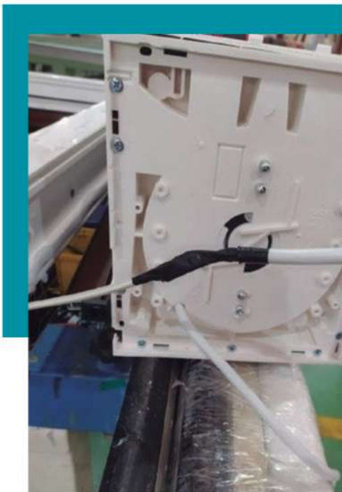
Vue du câble moteur relié à l'aiguille, prêt à être tiré vers le haut.
